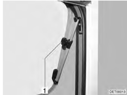
Bild 64 Överkantshängt fönster med vridspärrar, öppet
