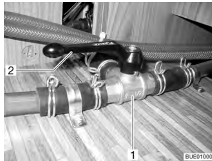
Fig. 161 Válvula de 3 vías
