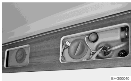
Fig. 94 Depósito de agua
