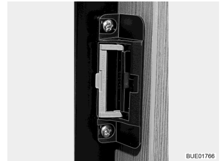
Afb. 82 Sluiting in ventilatiestand
