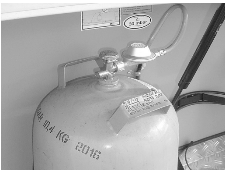
Fig. 103: Bombola di gas con valvola riduttrice di pressione
