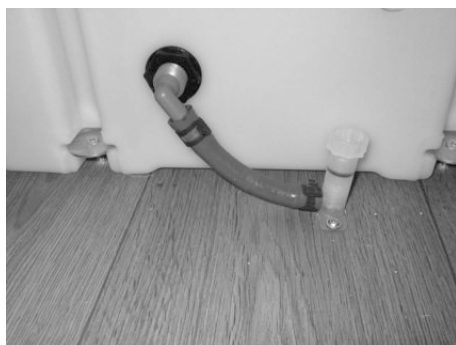
Fig. 89: Valvola di scarico, esempio
