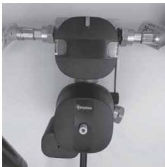
Abb. 116: Gasversorgung DuoControl CS
