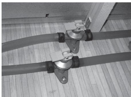
Abb. 179: Ablassventile geschlossen
