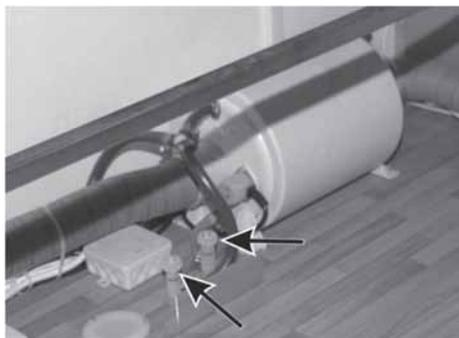
Abb. 99: TRUMA-Therme und Wasserablassventile
