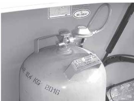
Abb. 75: Druckminderventil
