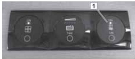
Abb. 137: Ein-/Aus-Schalter der Fußbodentemperierung
