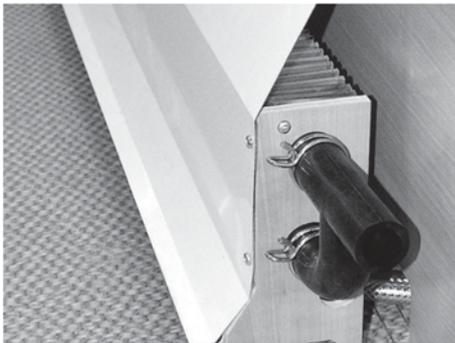
Abb. 90: Konvektor mit Wärmeleitblech
