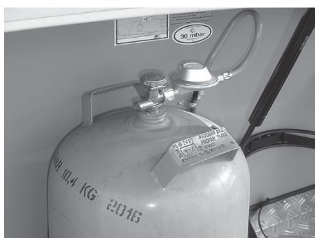
Afb. 114: Gasfles met drukverminderingsklep
