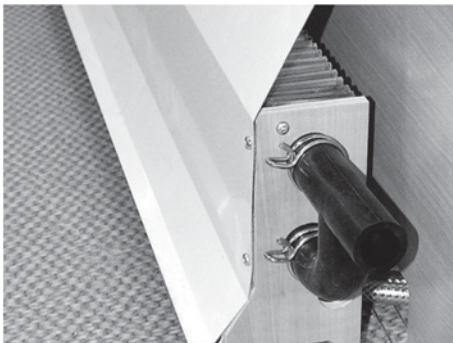
Afb. 90: Convector met warmtegeleidingplaat
