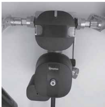
Afb. 116: Gasvoorziening DuoControl CS
