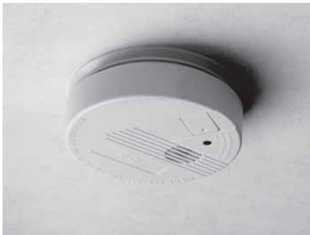
Fig. 32: Rivelatore di fumo
