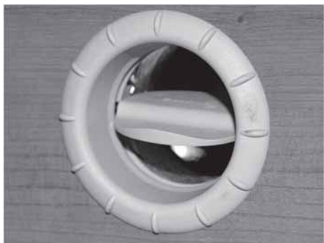
Fig. 110: Bocchetta dell'aria calda aperta
