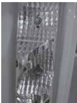
Fig. 147: Sostituire i corpi illuminanti
