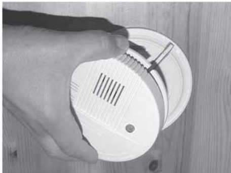
Fig. 93: Togliere l'alloggiamento
