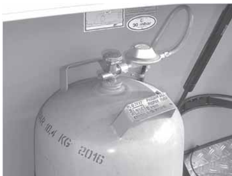
Fig. 69: Valvola riduttrice di pressione
