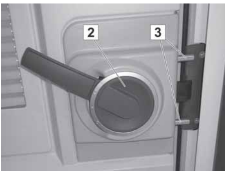
Afb. 15: Deur gesloten en geborgd
