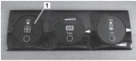
Abb. 122: Ein-/Aus-Schalter der Warmwasserbereitung
