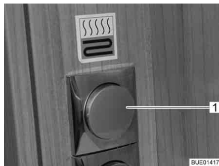
Fig. 119 Interruttore per il riscaldamento del pavimento nel vano WC
