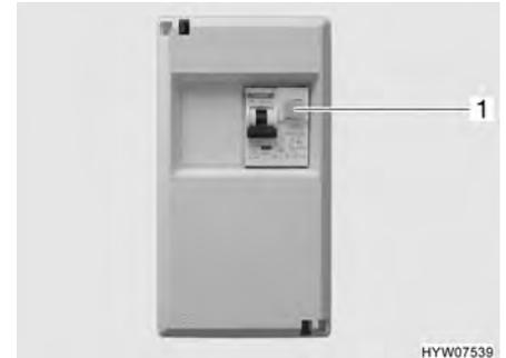
Fig. 105 Caja de fusibles de 230 V con interruptor de protección de línea e interruptor diferencial (FI)
