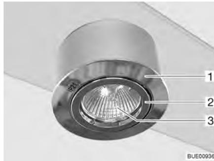
Bild 208 Halogeneinbauleuchte (schwenkbar)
