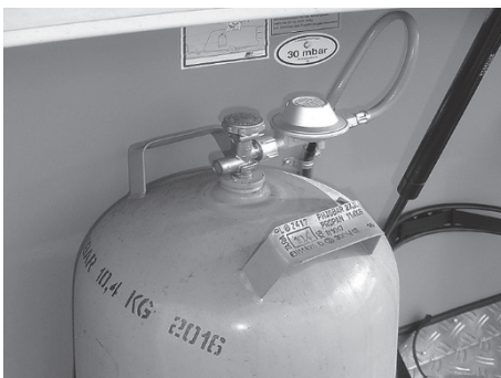
Afb. 101: Gasfles met drukverminderingsklep
