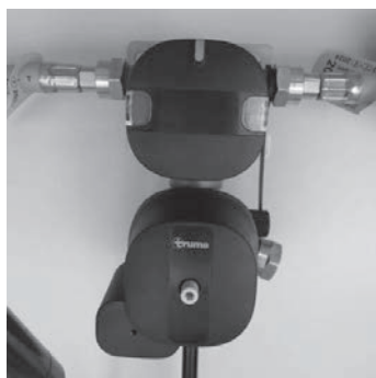
Afb. 103: Gasvoorziening DuoControl CS
