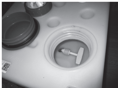
Fig. 89: Bundprop i drikkevandstanken
