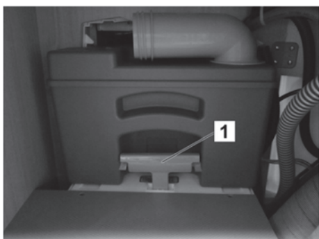
Fig. 143: Toilettank i tømmeskakten
