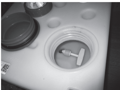
Fig. 97: Bundprop i drikkevandstanken
