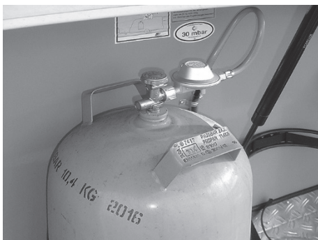
Fig. 101 : Bouteille de gaz avec détendeur
