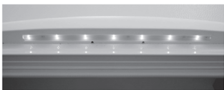
Fig. 71 : Eclairage de l'auvent à diodes électroluminescentes
