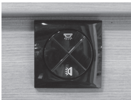
Fig. 37 : Boutons multifonctions pour l'éclairage (exemple)
