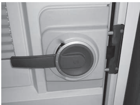
Fig. 13: Dørlås lukket, men usikret
