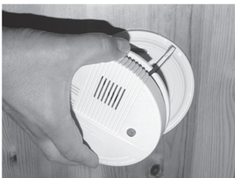
Fig. 108: Ta av huset
