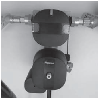
Fig. 77: Gassforsyning (med Eis-Ex og fjernvisning)
