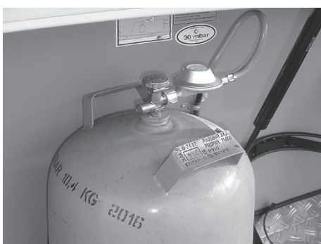
Fig. 101: Gassflaske med reduksjonsventil
