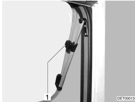
Kuva 120 Kattoluukku, jossa on kääntöpidikkeet, avattu
