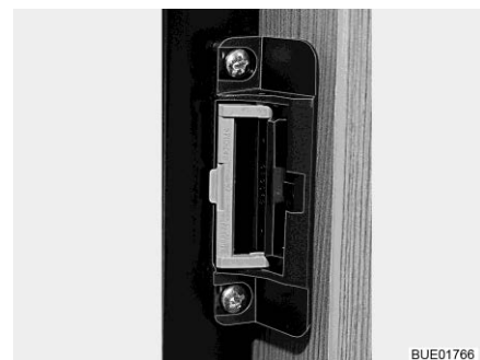
Kuva 246 Lukituslaitteisto tuuletusasennossa
