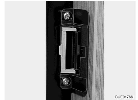
Billede 246 Låseanordning i udluftningsstilling
