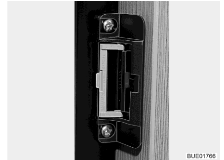
Bild 85 Låsanordning i ventilationsläge
