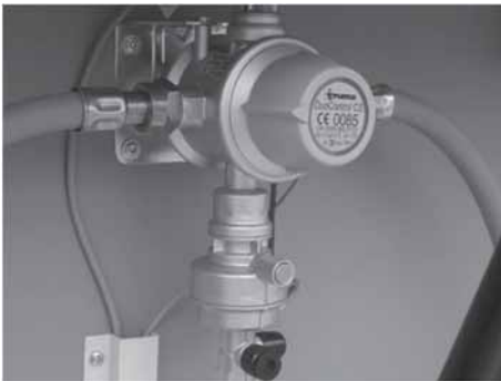
Fig. 76: Gassforsyning (med Eis-Ex og fjernvisning)
