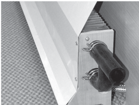
Fig. 88: Konvektor med varmeledende plate
