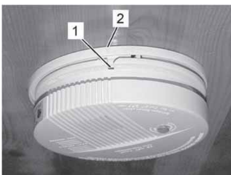
Fig. 218: Sett huset på plass
