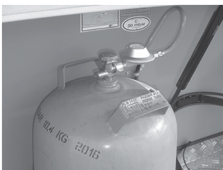
Fig. 112: Gassflaske med reduksjonsventil
