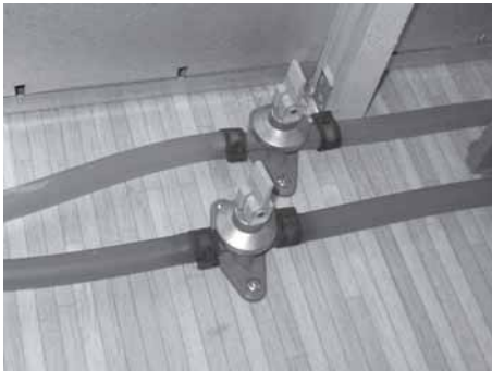
Fig. 100: Åpne tappeventilene
