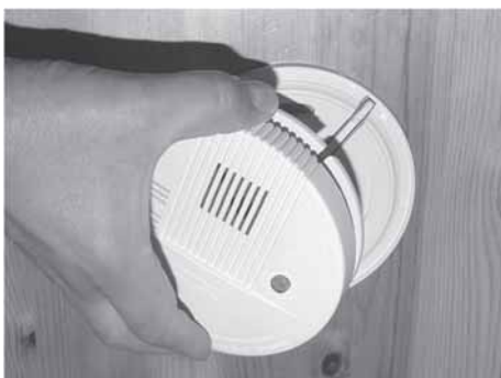
Fig. 216: Ta av huset
