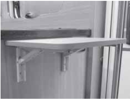
Fig. 200: Vippekonsoll for å forlenge kjøkkenarbeidsbenken
