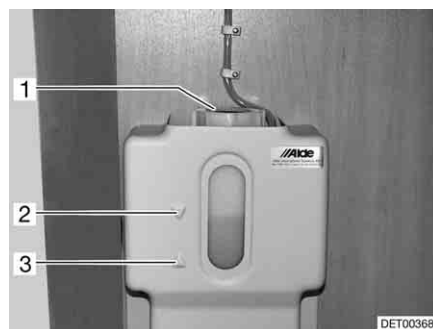
Bild 271 Ausgleichsbehälter mit Blende
