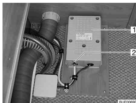
Bild 211 Trafo für elektrische Fußbodenerwärmung
