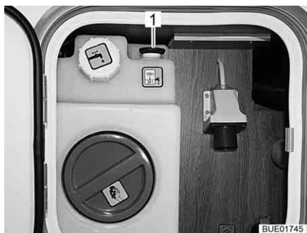
Fig. 247 Depósito de agua (unidad de alimentación centralizada)
