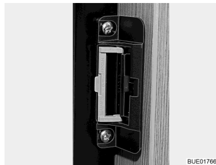
Fig. 167 Dispositif de fermeture en position de ventilation
