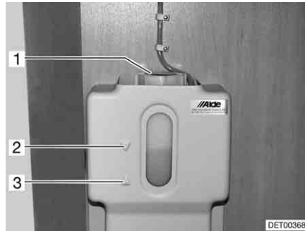
Fig. 194 Vase d'expansion pour le chauffage à eau chaude
