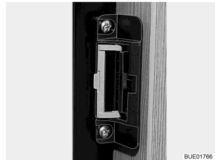
Bild 167 Verschlusseinrichtung in Lüftungsstellung
