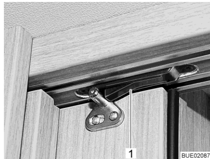
Bild 15 Raste mit Feder
