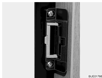
Billede 64 Låseanordning i udluftningsstilling
