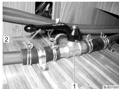
Fig. 237 Válvula de 3 vías
