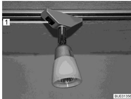
Afb. 75 Spotlight, lichtschakelaar direct bij de lamp
