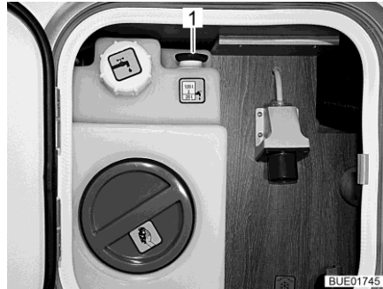
Bild 265 Vattentank (central försörjningsenhet)
