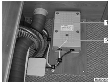
Bild 166 Trafo für elektrische Fußbodenerwärmung
