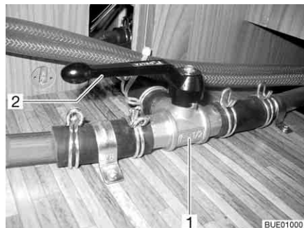
Fig. 198 Vanne à 3 voies
