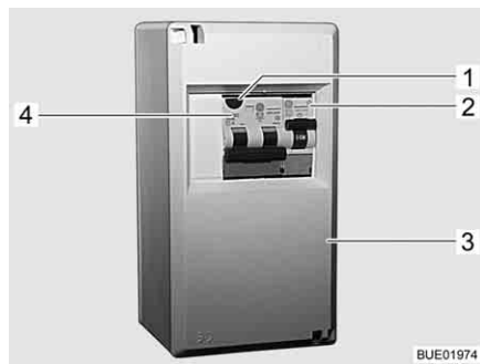
Fig. 181 Scatola dei fusibili a 230 V
