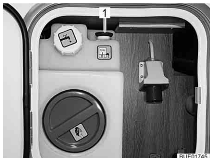
Fig. 242 Serbatoio dell'acqua (unità di alimentazione centrale)
