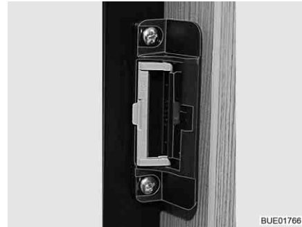
Afb. 236 Sluiting in ventilatiestand
