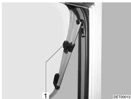
Bild 68 Överkantshängt fönster med vridspärr
