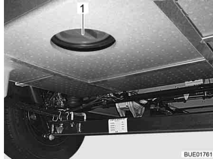
Fig. 159 Ouverture de nettoyage du réservoir d'eaux usées
