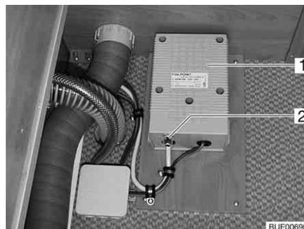
Bild 202 Trafo für elektrische Fußbodenerwärmung
