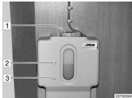
Bild 268 Ausgleichsbehälter mit Blende
