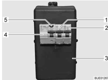
Bild 119 230-V-Sicherungskasten mit Leitungsschutzschalter und FI-Schalter
