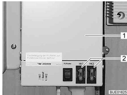
Fig. 116 Regolatore riscaldamento per tubazioni delle acque grigie
