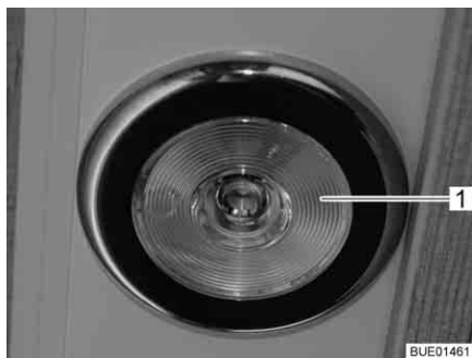
Billede 47 Indbygget lampe, lyskontakt i lampen
