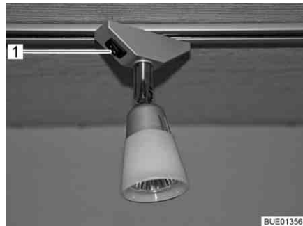
Bild 62 Spotlight, ljusbrytare direkt på lampa (exempel)
