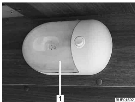
Fig. 272 Iluminação da garagem
