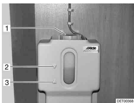
Fig. 254 Depósito de compensação com invólucro
