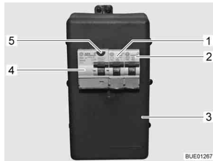
Fig. 178 Scatola dei fusibili a 230 V con interruttore di sicurezza e interruttore automatico FI
