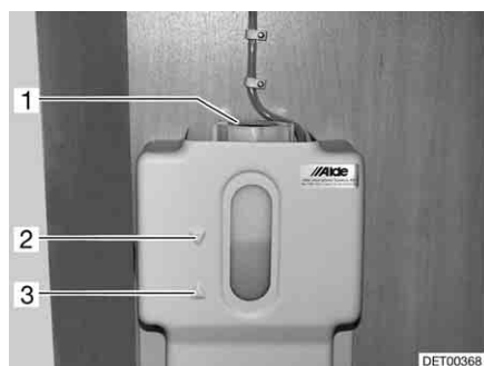
Billede 267 Udligningsbeholder varmtvandsvarmeovn
