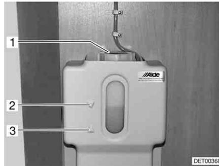
Bild 267 Ausgleichsbehälter Warmwasser-Heizung
