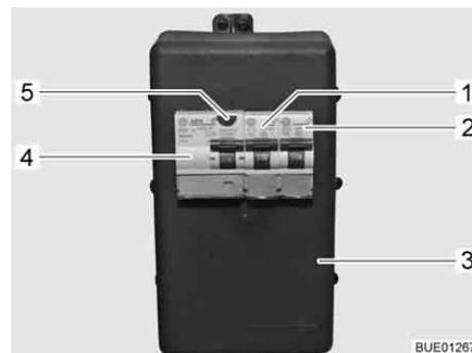
Bild 167 230-V-Sicherungskasten mit Leitungsschutzschalter und FI-Schalter
