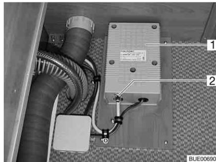
Fig. 186 Transformador para calentamiento eléctrico del piso
