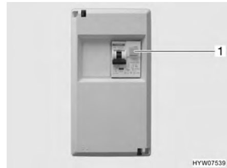
Billede 117 230 V-sikringsskab med lednings- og fejlstrømsrelæ (FI)
