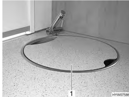
Fig. 11 Cubierta del fregadero
