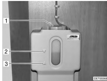
Fig. 196 Recipiente de compensación para la calefacción de agua caliente
