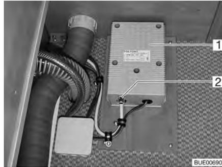
Bild 144 Trafo für elektrische Fußbodenheizung
