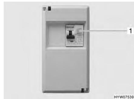
Bild 123 230-V-Sicherungskasten mit Leitungs- und Fehlerstrom-Schutzschalter (FI)
