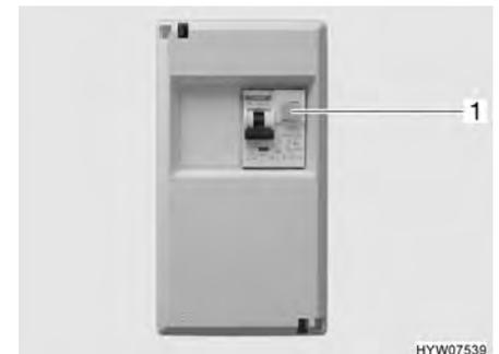
Fig. 123 Scatola dei fusibili a 230 V con interruttore di protezione della linea e interruttore di sicurezza per correnti di guasto (FI)
